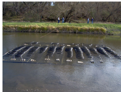
(D) Submerged Pond Loop
